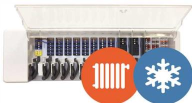
Para a superfície de aquecimento e arrefecimento de sistemas em combinação com até 8 controladores °CALEON Clima. O controle de ponto de orvalho contínuo em cada habitação garante a operação segura e eficiente do arrefecimento.
